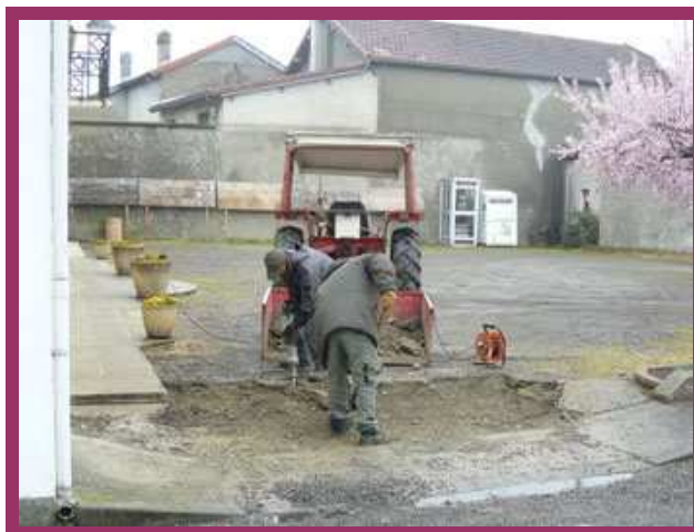
Travaux sur la nouvelle rampe d'accès à la Mairie
