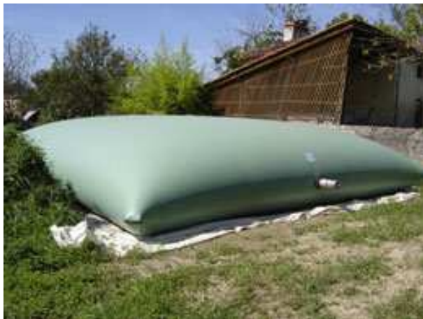
La réserve incendie, lors de sa mise en place...
